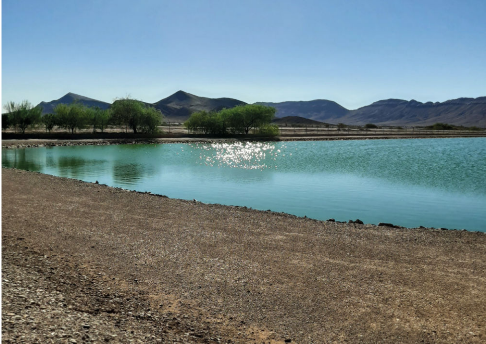
Station d'épuration de Tata, © pS-Eau, septembre 2024
