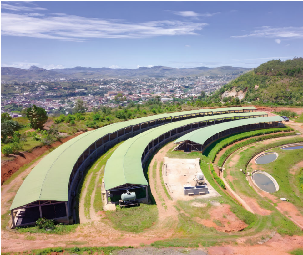
Station de traitement des boues de vidange de Fianarantsoa, Madagascar, © Practica Foundation
